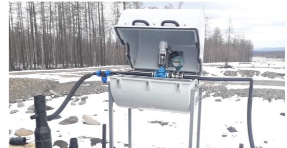
Новое скважинное оборудование (ПЛК Siemens, р/меры Yokogawa, Ризур-боксы)
