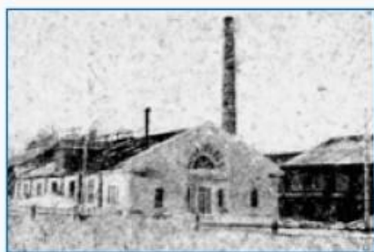
Здание опытного Бондюжского завода (1922)
