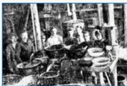
Установка для разделения бария и радия на опытном заводе
