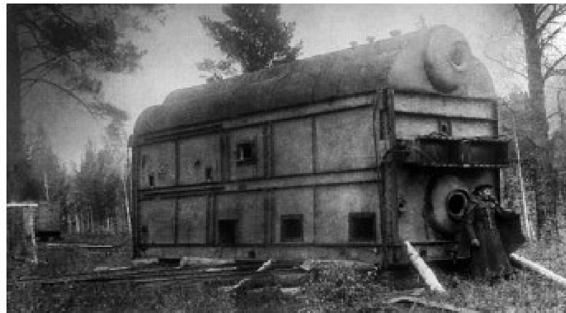
Котёл паротурбинной электростанции «Петер Лофтус»
