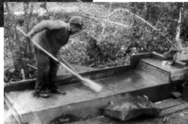
Справа – железный противень для сушки готового концентрата
