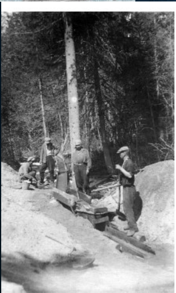
Промывка эфелей на старательской бутаре ключа Монциговьей
