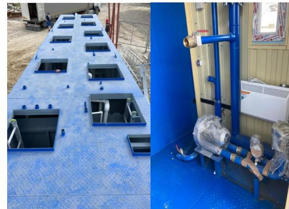
«Очистные сооружения бытовых стоков ЛОС-Р-45» от ООО «АИС». Июнь 2021г.
